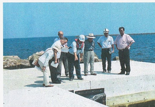
昨年9月、野辺地港湾整備建設場所を委員会メンバーで視察
